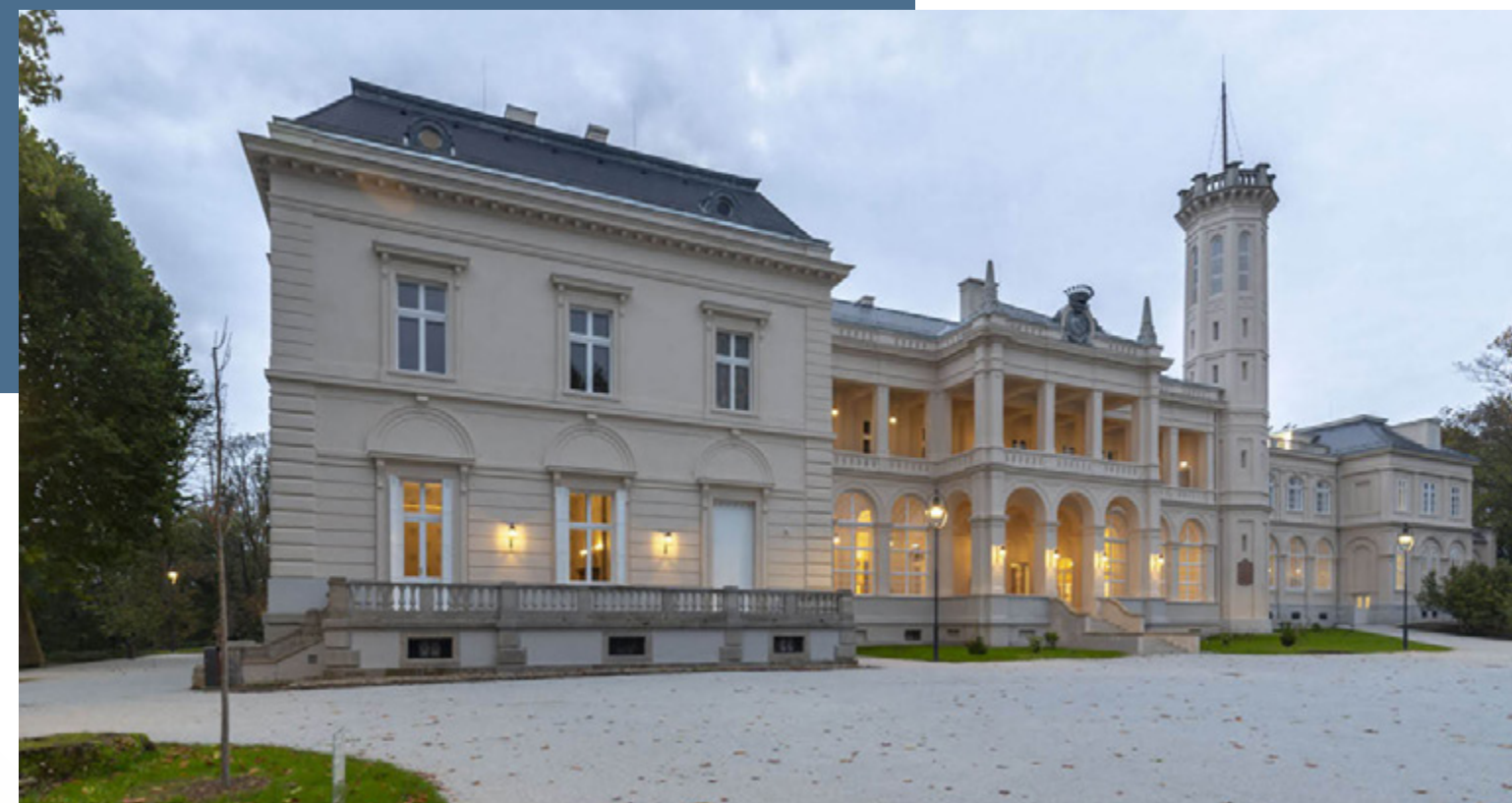
FÜZERRADVÁNYI KASTÉLYKERT FELÚJÍTÁSA
